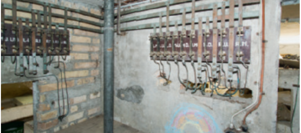
2021: Die Scheune mit der noch erhaltenen Elektroinstallation.
